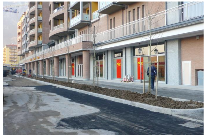
Figura 2 Complesso residenziale/commerciale – Lecco
