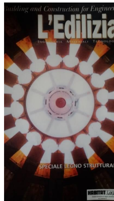
arco a tre cerniere in cui confluiscono sedici travi di legno lamellare nella chiesa di Andalo
