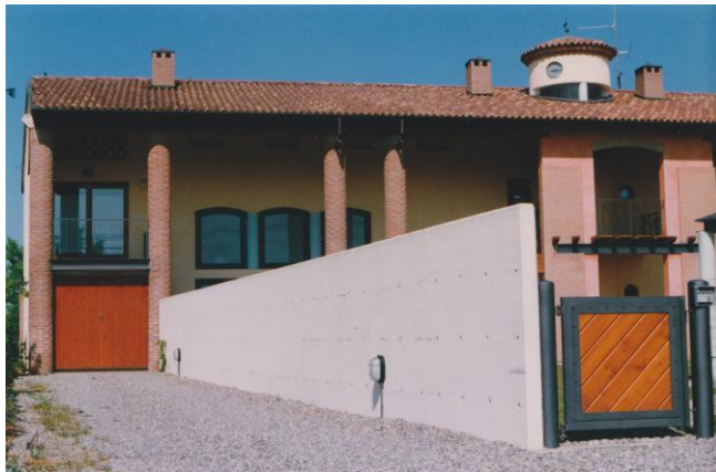
Ristrutturazione di edificio rurale Palazzolo sull'Oglio
